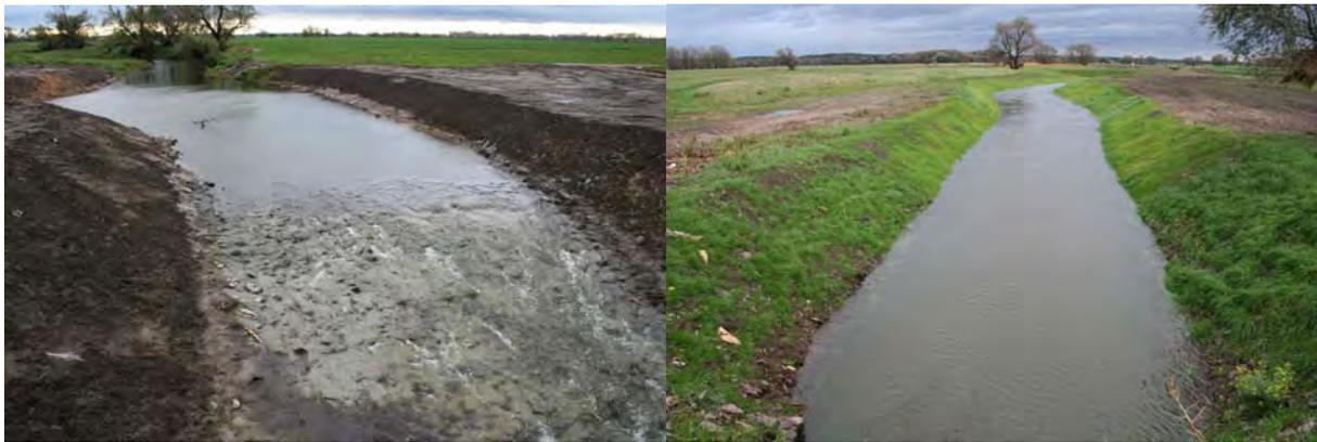
*Abbildung 6 Gefluteter Zulauf zum Altwasser (rechts) und Sohlbauwerk als Zwangspunkt zur Umlenkung der Ehle in die Alte Elbe Lostau am 08. November 2013 (Bauabnahme)*
